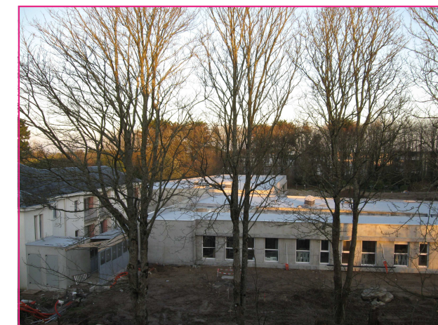
Vue du chantier de Keraudren
