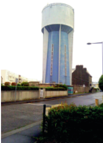
Un des deux châteaux d'eau construits à Kerourien en 1930
