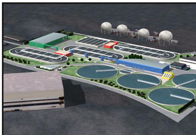
Station d'épuration de la zone portuaire
