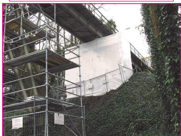
Bâchage des piles du pont
