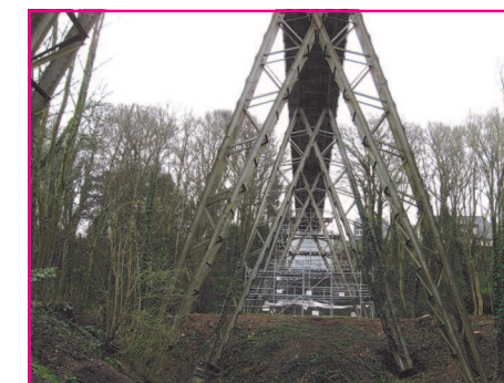
Vue de dessous du pont
